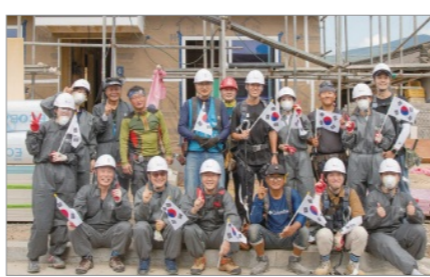
해비타트와 가수 선이 주최한 815런 문화행사, 10호로 손진구 선생 후손의 집 공사 현장 모습이다. ©한국 해비타트
